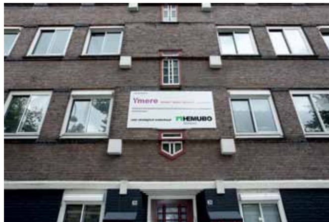
Woningcorporatie Ymere is de opdrachtgever voor de renovatie
